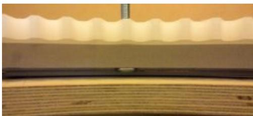
Im Profil sieht jetzt der ganze Dome-Unterbau so aus: oben der Holzring, der mit dem Inneren Dome verschraubt wird, dann der Zahnkranz, als nächstes der Drehkranz und ganz unten die PS-Abstandshalter.
